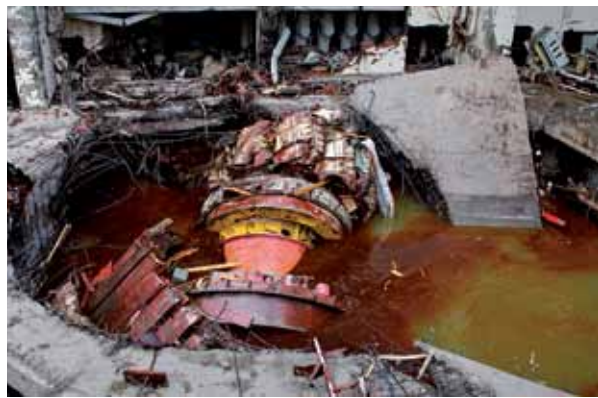
Рис.2. Разрушения на Саяно-Шушенской ГЭС
