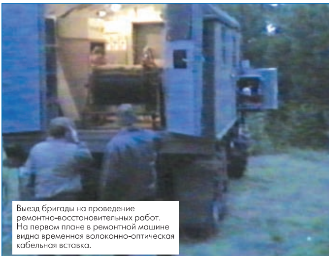
Рис.7 Развертывание и эксплуатация одноэлементной ВОКВ протяженностью 4 км
