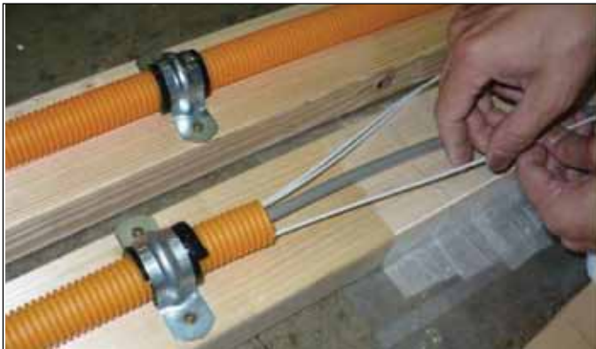
Проталкивание в кабельный канал
