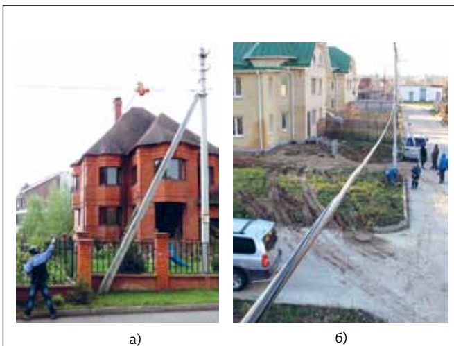
Рис.13. Навивка оптического дроп-кабеля: а – навивка машинкой; б – кабели, навитые на ОКЧН
