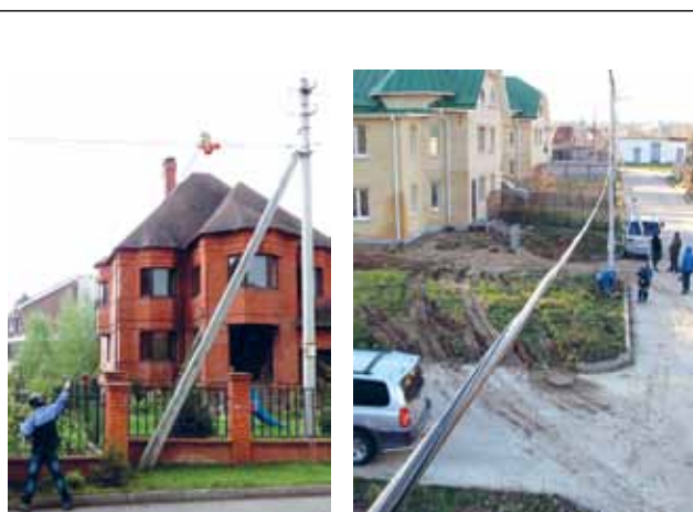
Рис.13. Навивка оптического дроп-кабеля: а – навивка машинкой; б – кабели, навитые на ОКЧН
