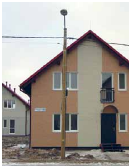
Рис.4. Пример компактного расположения элементов сети FTTH. Жилой район Новая Ижора под Санкт-Петербургом. Дроп-кабели проходят к домам от опоры в подземных пластиковых трубах
