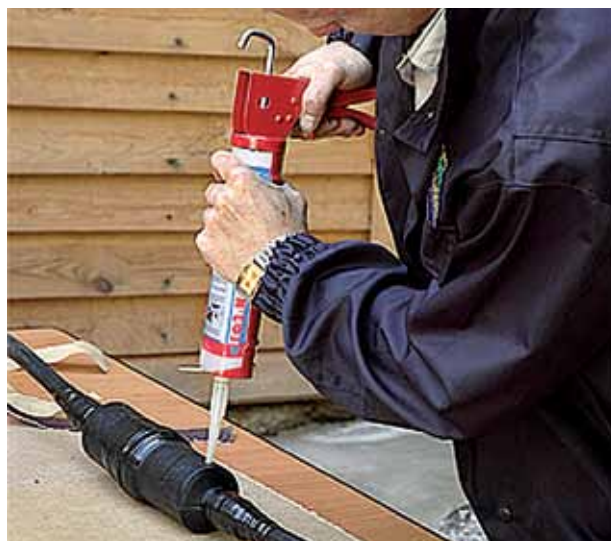
Рис.3. Восстановление муфты с помощью заполнителя ГФЗ-МНТ
