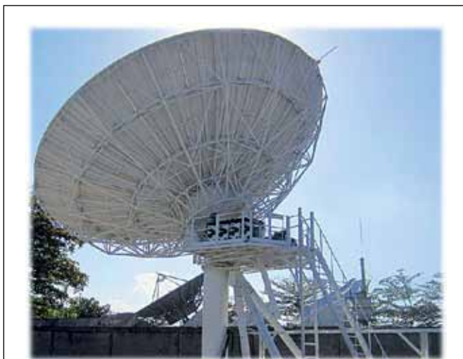
Рис.3. Реализация передающей части головной станции DTH на базе GaN ПУМ и системы фазового сложения компании Advantech Wireless
