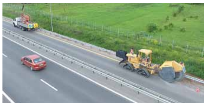
Рис.1. Строительство микрокабельной канализации на федеральной трассе М-3 "Украина"
