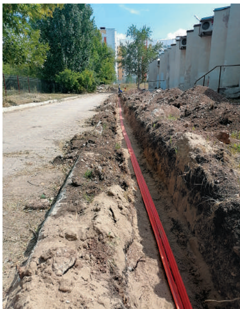
Рис.2. Прокладка пакета микротрубок
