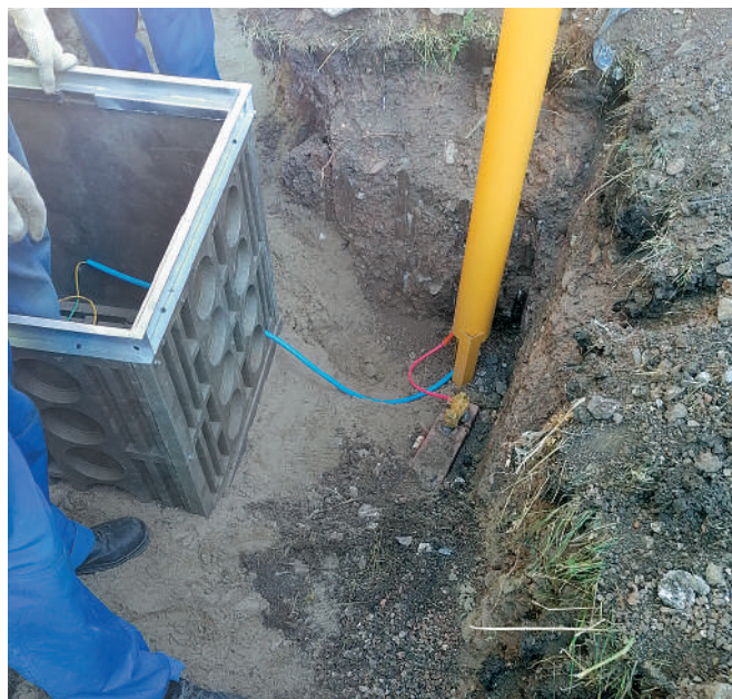
Рис.1. Установка смотрового устройства и СКИП
